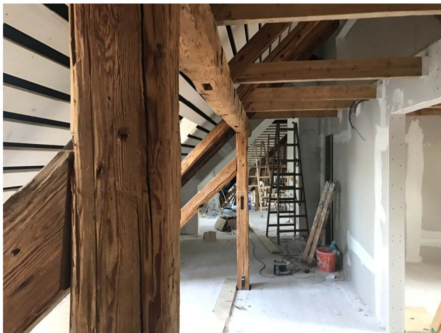
TROCKENBAUARBEITEN UND AKUSTIKSCHALUNG
