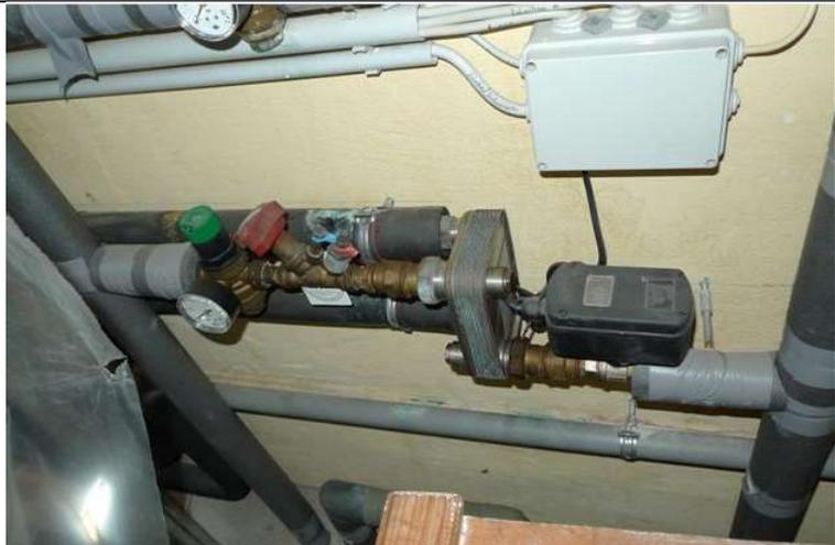
Abbildung 41: offensichtlich zu klein dimensionierter Plattenwärmeübertrager Grundwasser - Sole (Leitzinger, 2013)
