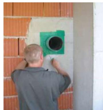
Abb. 3-74: Fortluftdurchführung durch Ytongfeld
