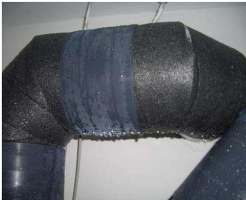
Abbildung 42: Kondensatbildung an einer geschäumten Luftleitung in einer Reihenhausanlage (Leitzinger, 2013)
