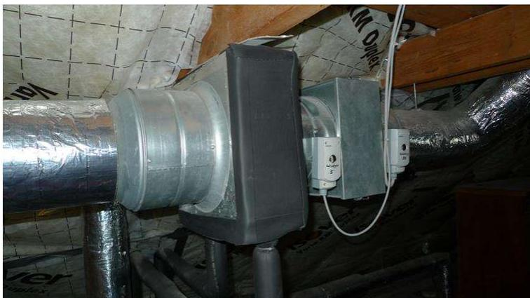
Abbildung 39: Heizregister statt Kühlregister verbaut – fehlender Kondensatablauf (Leitzinger, 2013)
