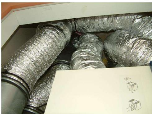
Abbildung 43: undämmbare hochflexible Außenluft- und Fortluftleitungen (links) in einem engen Haustechnikschacht in einer kleinen Wohnhausanlage (Leitzinger, 2013)
