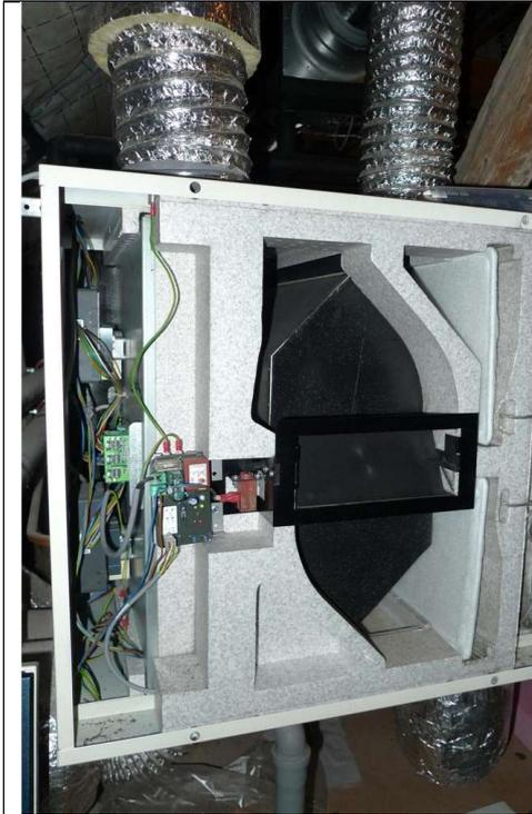
Abbildung 40: Gerätinnenseite mit Plattenwärmetauscher und störanfälliger Bypassklappe (Leitzinger, 2013)
