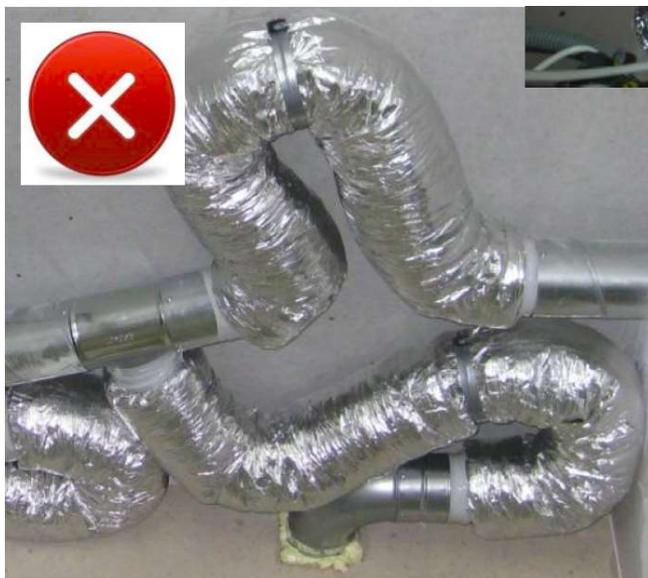
Abbildung 22: Beispiel eines nicht reinigbaren Leitungssystems in einer Zwischendecke (Leitzinger, 2013)
