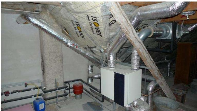
Abbildung 38: Lüftungsinstallation im nicht konditionierten Dachboden (Leitzinger, 2013)
