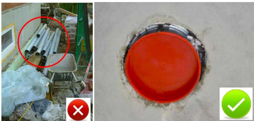
Abbildung 33: Nicht korrekt gelagerte Rohre (links), während der Bauphase verschlossene Rohrleitung (Leitzinger, 2013)
