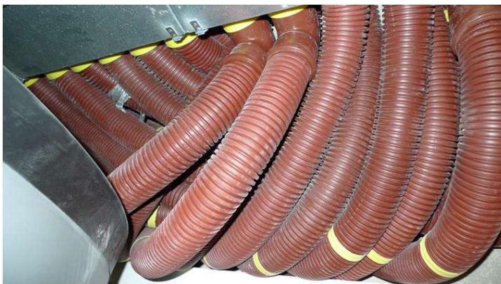
Abbildung 46: große Schlauchbündel nach Verteilbox (Leitzinger, 2013)
