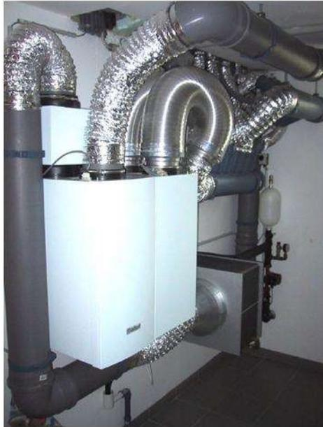
Abbildung 44: hochflexible, undämmbare Außenluft- und Fortluftleitungen in einem Einfamilienhaus (Leitzinger, 2013)
