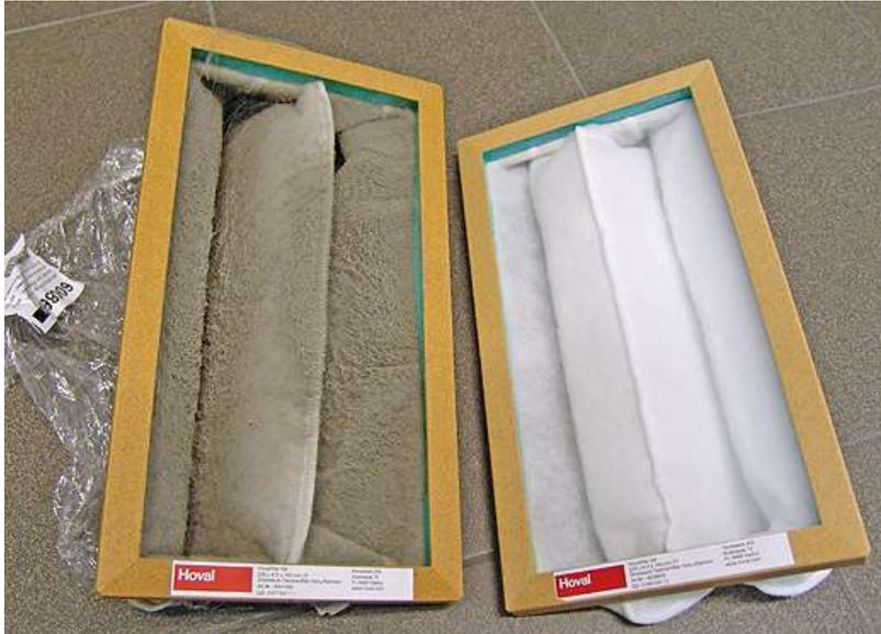
Abbildung 15: Abluftfilter einer Wohnraumlüftung links nach einem Jahr, rechts neu
