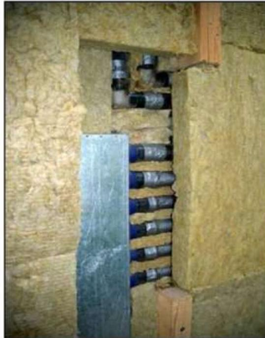
Abbildung: Leitungsführung in der Außendämmung (Quelle: AWEL)
