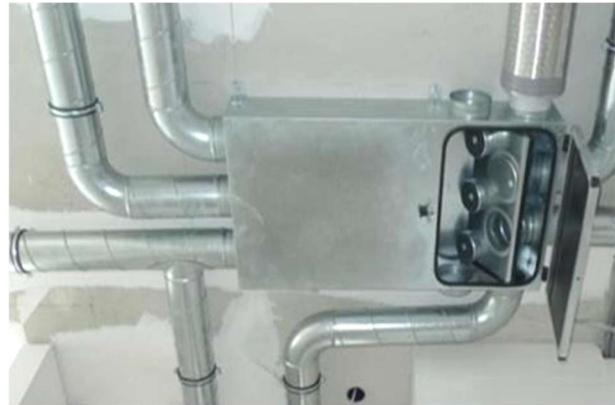
Abbildung 31: Kombinierte Verteilbox für Zu- und Abluft zur Auskreuzung von Luftleitungen
