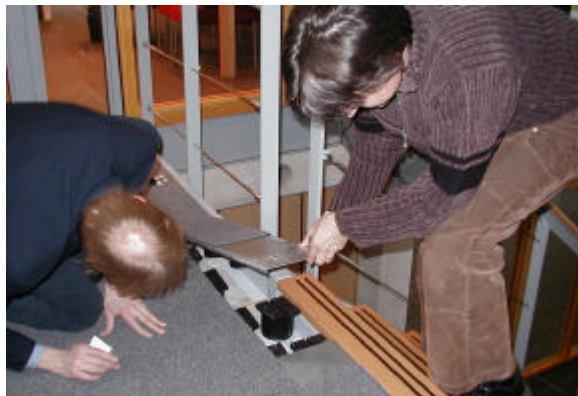
Abb. 14: links: Die Fußböden sind Metallelemente und beinhalten die Installationen, Belag ist Teppichboden nicht verklebt. Abb. 15: rechts: weitere Bodenaufbauten
