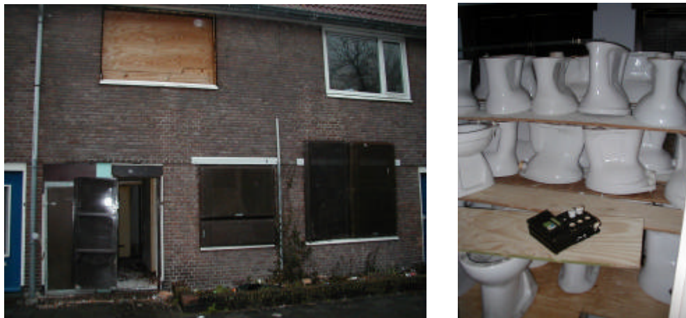
Abb. 25, 26: Den Haag: Gebäude wird vor dem Abbruch mit Metallplatten gegen Vandalismus gesichert und verwertbare Teile ausgebaut und zwischengelagert.
