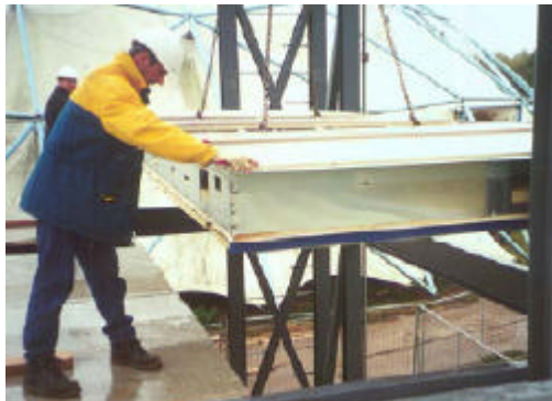
Abb. 20: Zusammenbau der Fußbodenpanele
