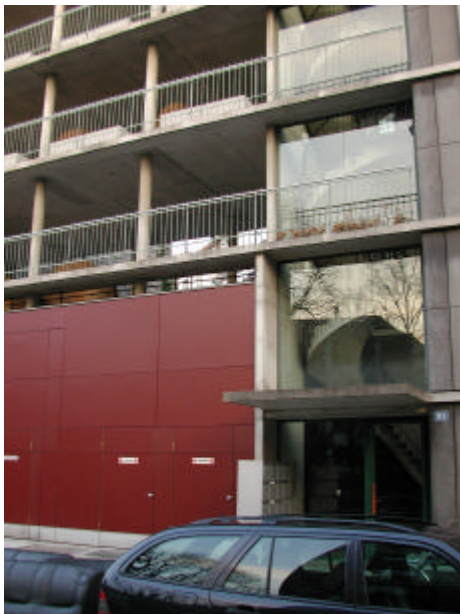
Abb. 33: Fassade vorgefertigt, aus gefärbten Holzelementen, demontabel
