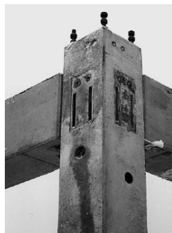
Abb. 2a: Vierseitiger Riegelanschluss an eine Stütze, mit Öffnung für die Integration eines Infocode-Chips mit den Daten der Stütze (BES System Finnland: Geometrie-, Bemessungs- und Recyclingdaten können zu einem beliebigen Zeitpunkt wieder ausgelesen werden, siehe auch Kapitel 4)
