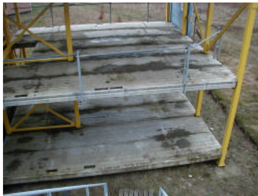
Abb. 17: Die tragende Grundkonstruktion mit den Ausnehmungen für Stiege und Installationen.
