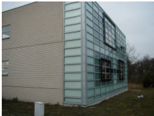
Abb. 18: Die Ziegelwand wurde industriell vorgefertigt, die Holz-Fensterrahmen mit Fixverglasung sind ein Standardprodukt.
