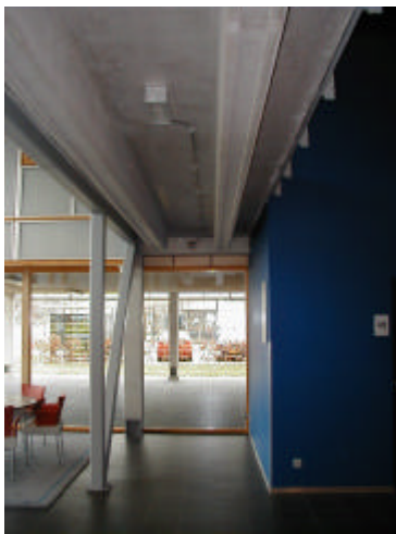
Abb. 13: Bouwcentrum international. Die Außenwand ist eine hinterlüftete (unten offene, oben mit Klappen öffnende) Klimafassade, die Wand besteht aus elementierten Holzrahmen mit Polycarbonatfassade, Wärmedämmung und innen Holzpaneelen.
