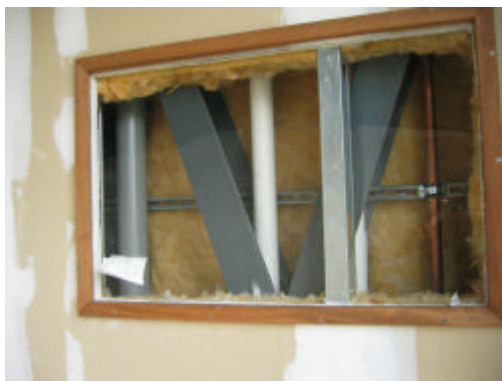
Abb. 21: Blick in eine Innenwand
